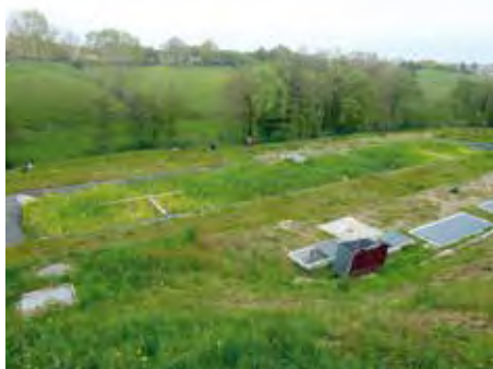
Station d'épuration à filtres plantés de roseaux à Mornant la Plaine.
